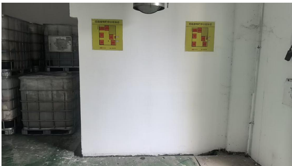
导流渠、地面防渗
