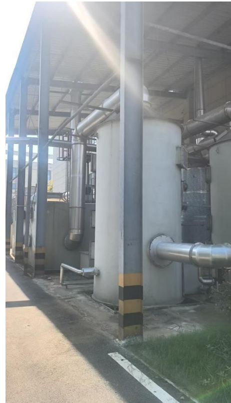
碱喷淋洗涤+生物除臭装置（两套）
